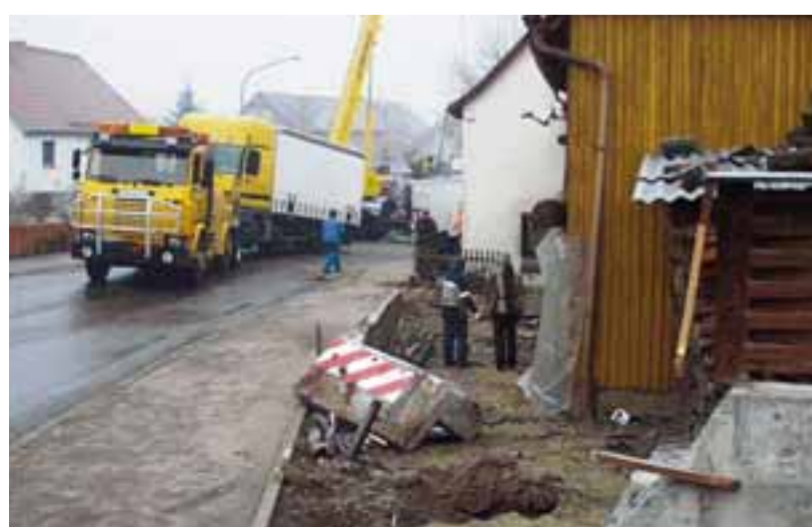
Für 13 Stunden gesperrt war gestern die St 2018 in Nattenhausen, nachdem ein Laster gegen eine Betonmauer geprallt war. Mit dem Kran musste er auf einen Abschleppwagen gehievt werden. Foto: Foto-Weiss
